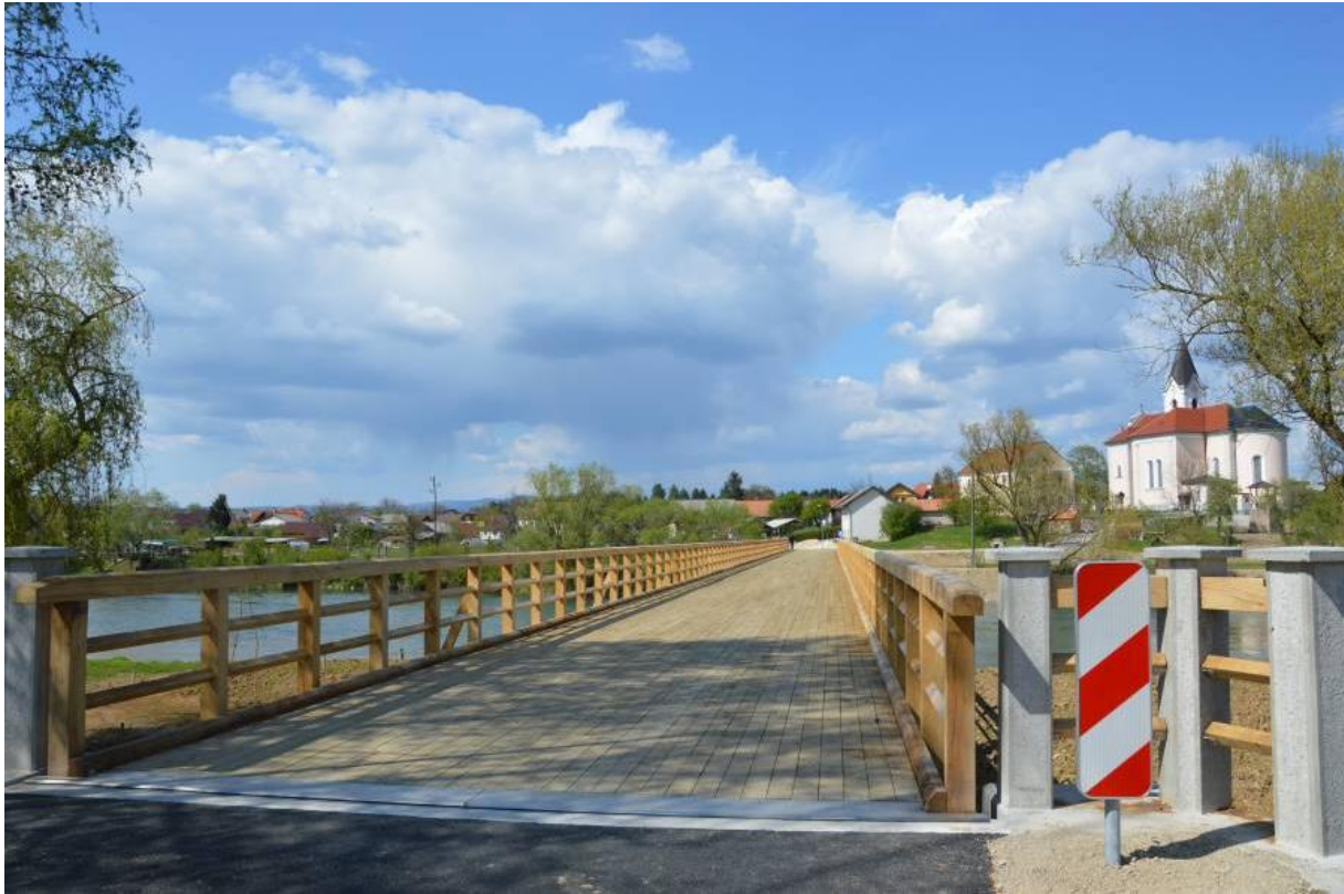
Obnovljen most v Cerkljah ob Krki (2021).
