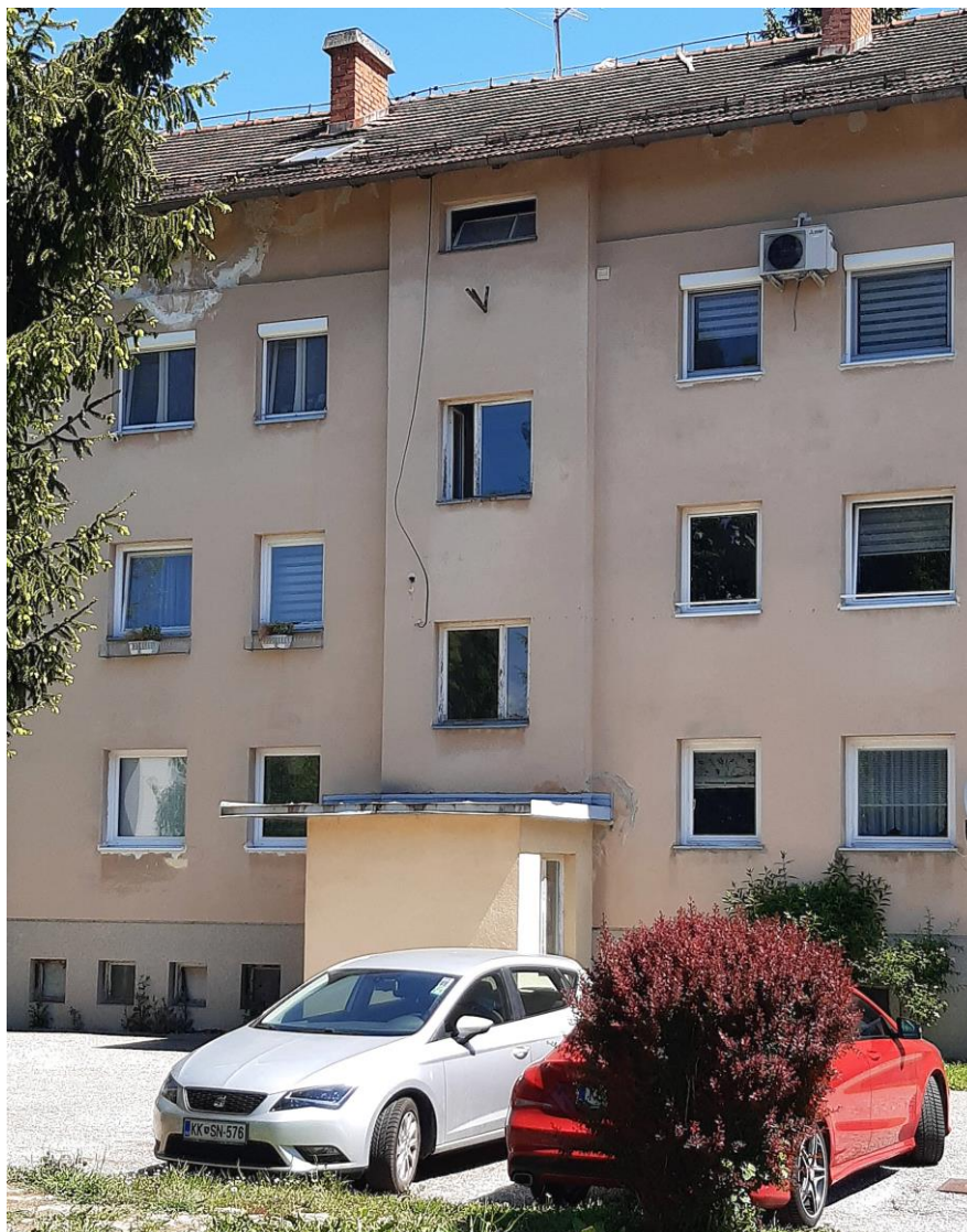
Vhod v Murnovo 4 v novi koloniji v Brežicah. Pločevinasta streha nad vhodom v blok, je bila ena od igrišč za najmlajše stanovalce bloka.
